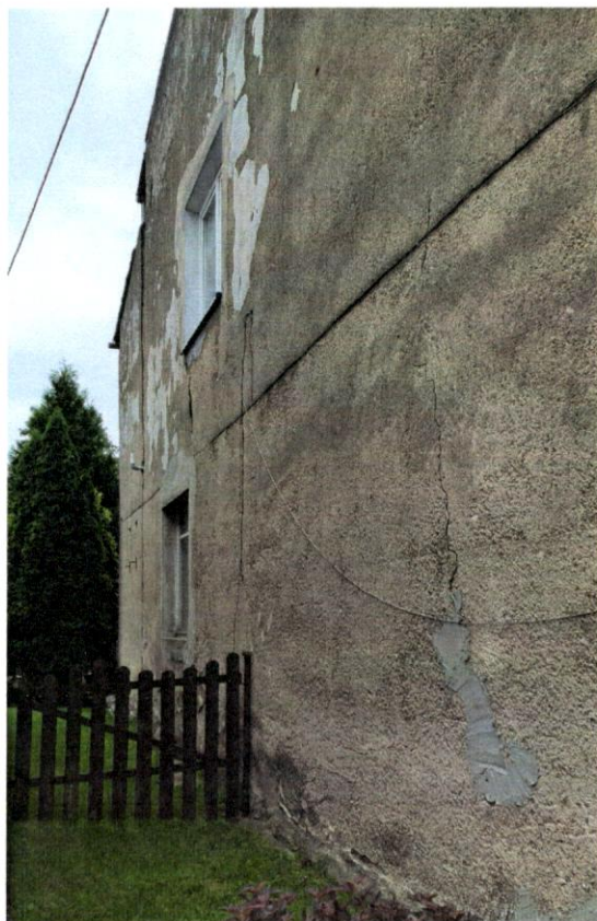
Fot.2 Wzmocnienie ściany szczytowej budynku
