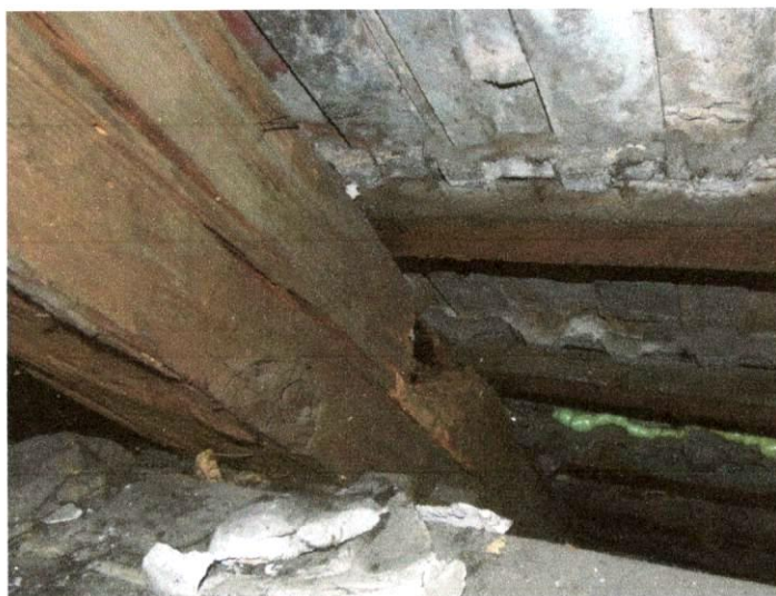
Uszkodzenie krokwi
