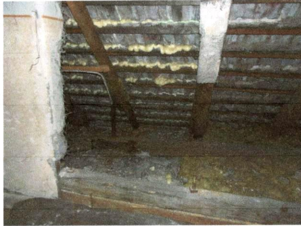
Przykład wadliwego wzmocnienie krokwi
