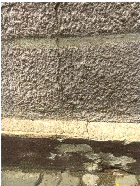
Pęknięcie ściany i fundamentu
