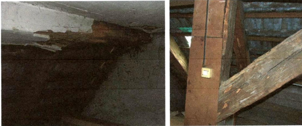
Obudowa uszkodzonych elementów
