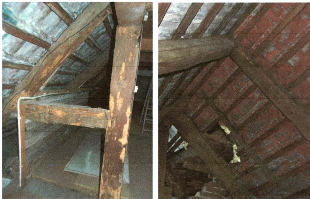
Widok połaci dachowej z ponadnormatywnym ugięciem krokwi i zaburzoną linią kalenicy
