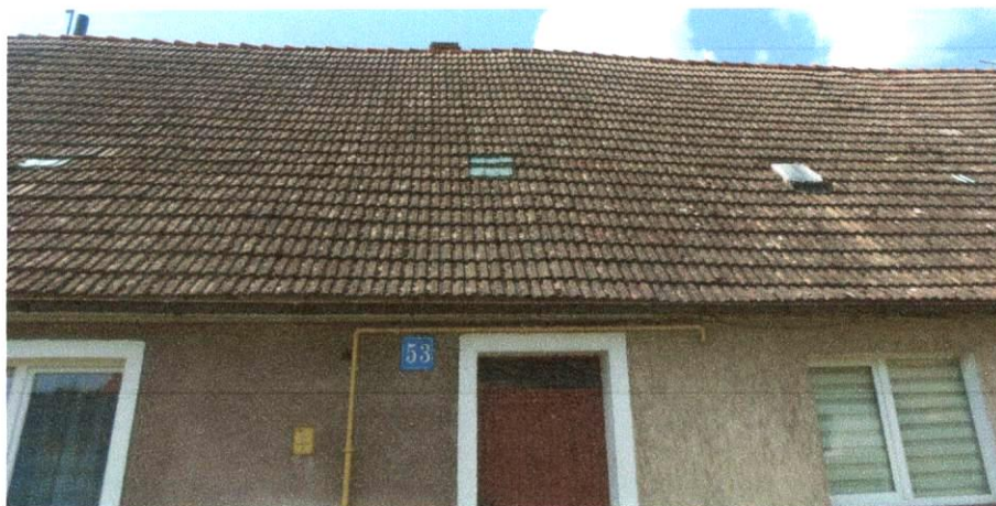
Widok połaci dachowej z ponadnormatywnym ugięciem krokwi i zaburzoną linią kalenicy
